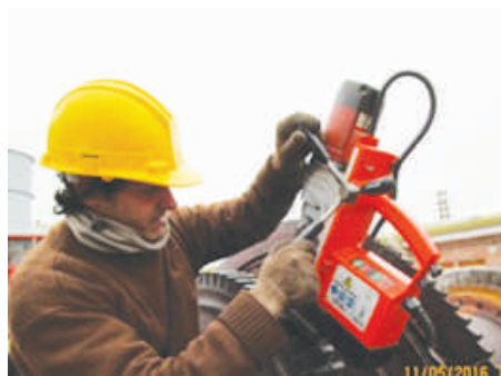
▲ Adaptación del rotor para colocar nuevos álabes de segunda etapa.
