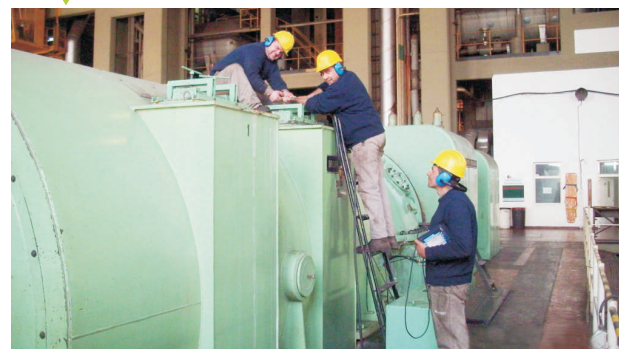
▲ Personal del Taller Mecánico reparando el refrigerante de aire del alternador de la TV7. (Sergio Aizpun, Martín Bengochea y Daniel Sottile).
