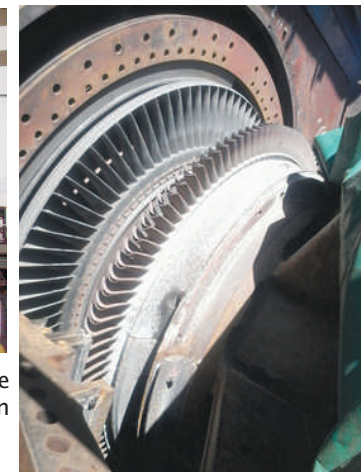
▲ Mantenimiento de turbina N° 21. Reemplazo de componentes internos. (álabes, segmentos térmicos y toberas) Reparación del tanque pulmón de gas, remetalado de cojinetes de turbina y generador, colocación de nuevos radiadores de refrigeración de agua.
