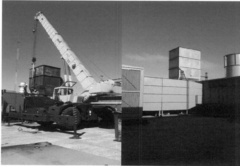
Reparación chimenea. Imágenes previa y posterior.
