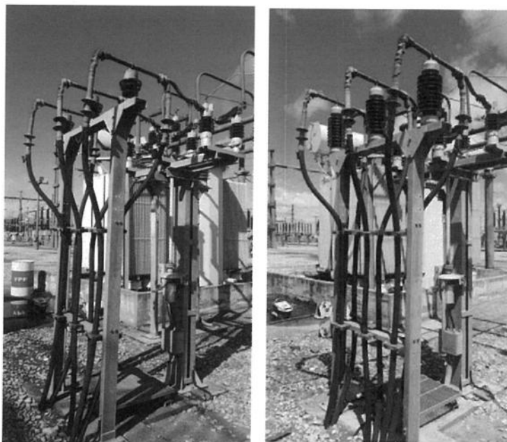
Reemplazo de aisladores de soporte 15kV y colocación aisladores de soporte 35kV
