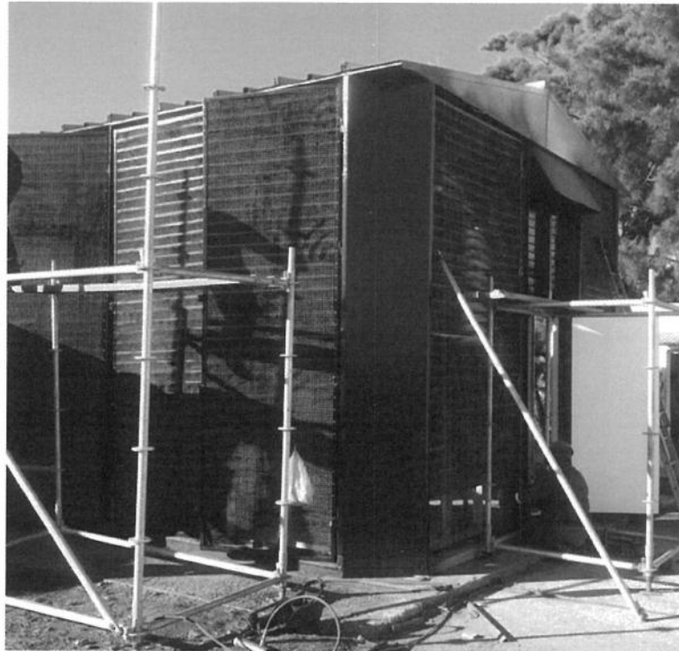
Reparación integral casa de filtros
