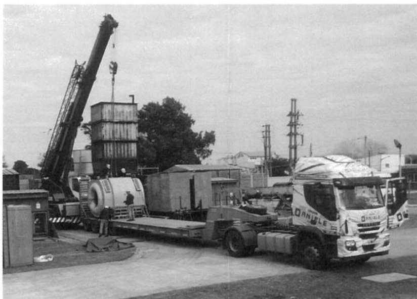
Montaje generador reparado
