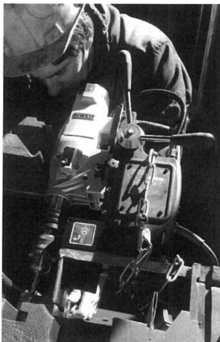
Reforma carcasa de turbina para montaje de 2da etapa de turbina con mejoras de sello.
