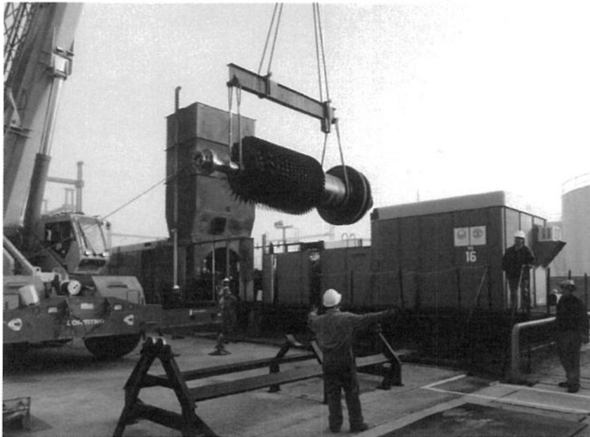
Extracción rotor turbocompresor
