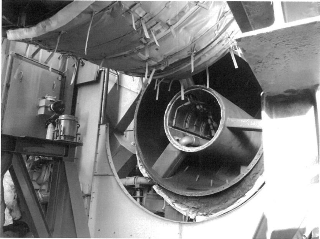
Montaje de nuevo ducto de transición de escape
