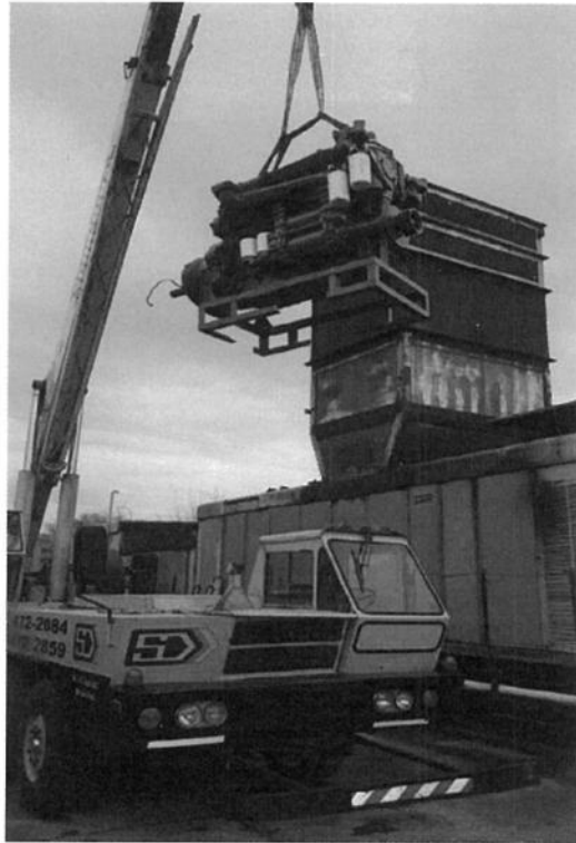
Motor Detroit en proceso de montaje
